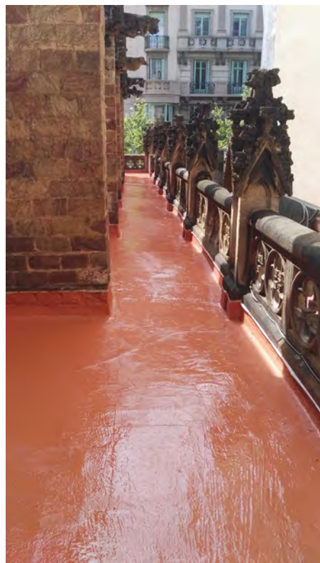
Impermeabilització de les cobertes
