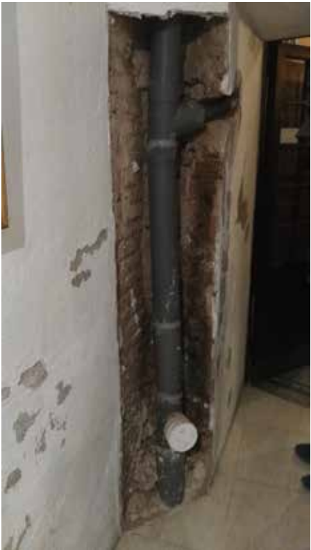
Bajante de la sacristía
