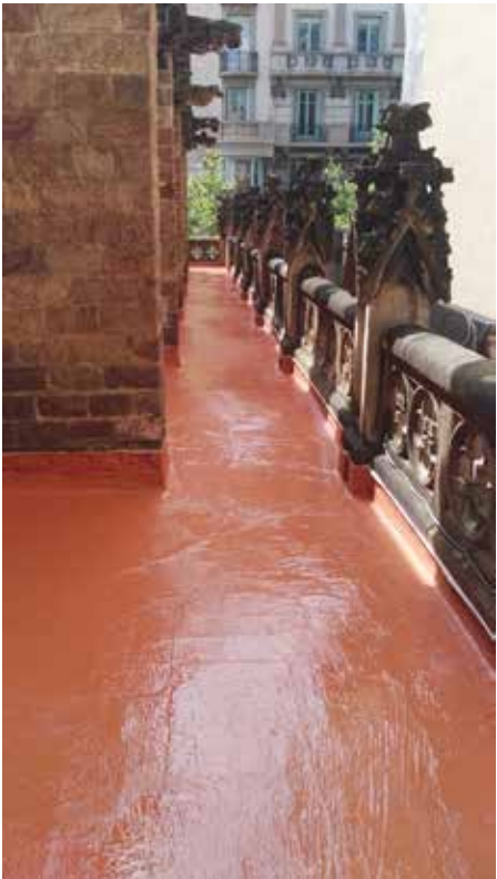
Impermeabilización de las cubiertas
