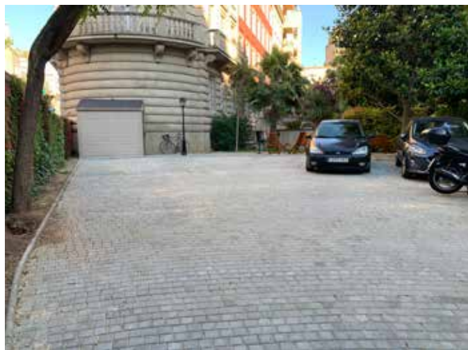
Aparcamiento patio central
