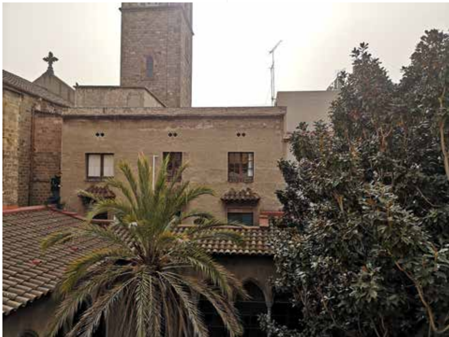
Estat inicial façana posterior
