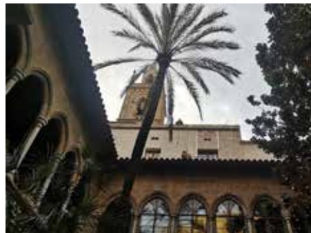
Procés d'obra façana posterior
