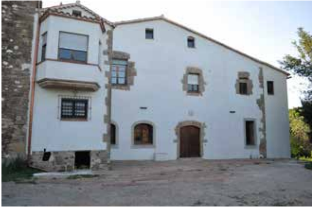
Després de la rehabilitació
